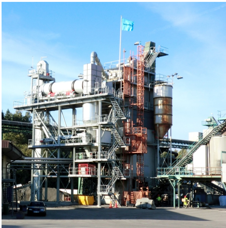
Bild 3. Skanskas asfaltverk i Dalby med utrustning för återvinning av både kalldoserad och uppvärmd returafalt.
